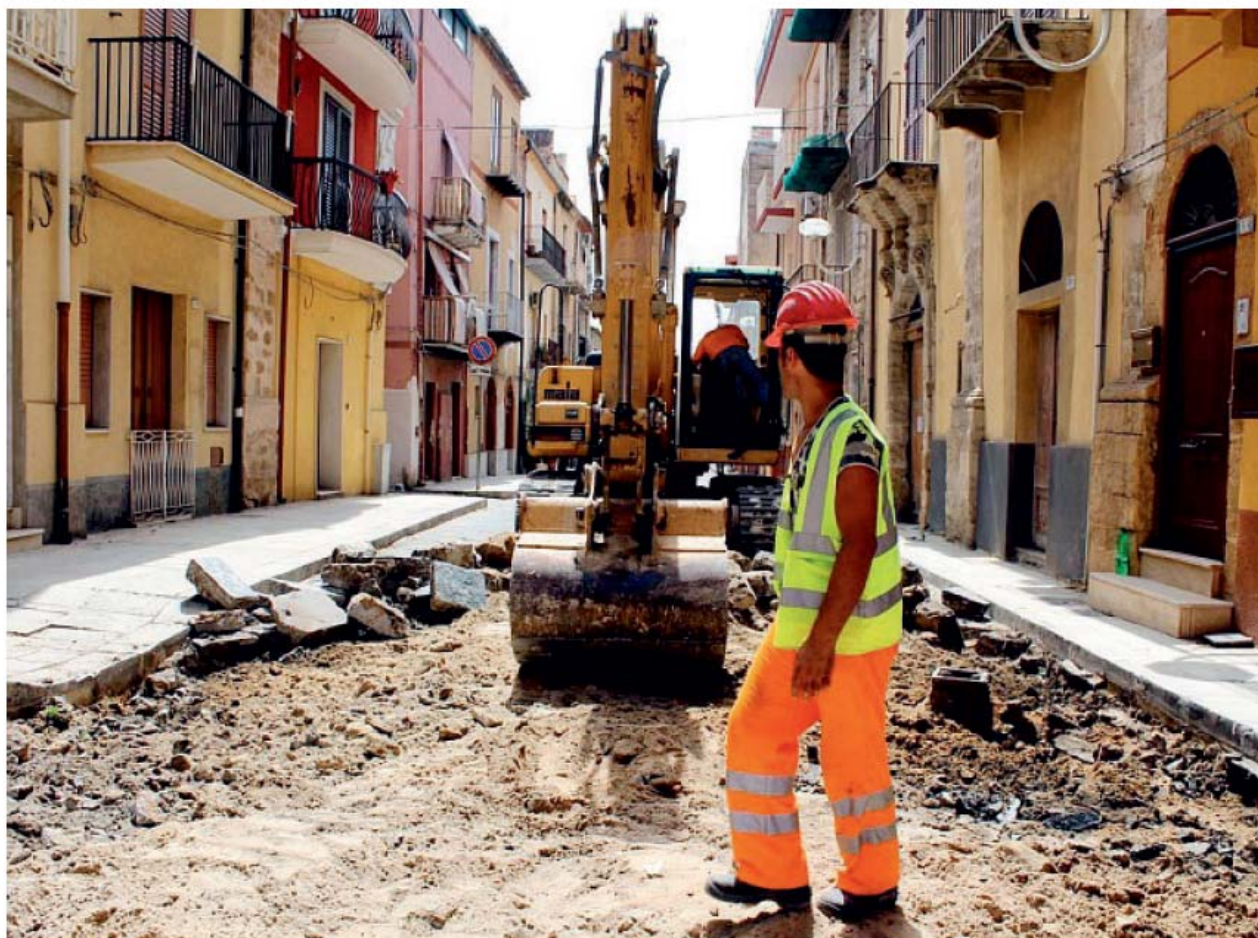
Nella foto d'archivio, lavori di rifacimento della rete idrica a Gela
